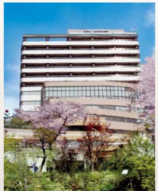
▲六本木ヒルズ現社屋「ハリウッドビューティプラザ」
